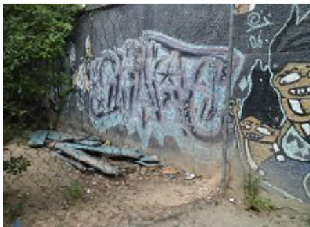
Alambrado danificado – área externa próximo à quadra
