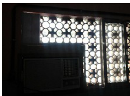
Ausência de vedação (ambiente climatizado) - sala 6
