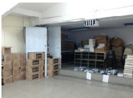
Auditório sendo utilizado para guarda de material
