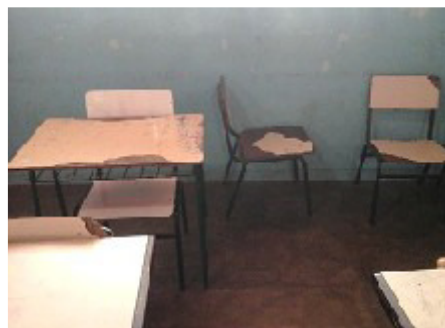
Mobiliário precário (situação sinalizada desde 2014)
