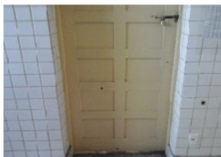
Banheiro desativado – 1º andar (situação sinalizada de 2008 a 2013)
