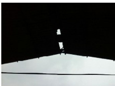
Telhado danificado (situação sinalizada desde 2014)
