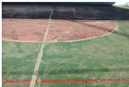
Piso danificado (situação sinalizada em 2012 e 2015)
