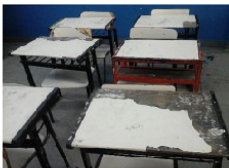
Mobiliário precário (situação sinalizada desde 2012)
