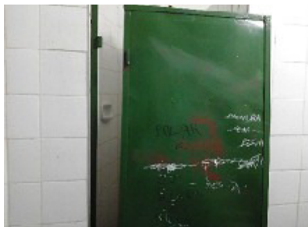
Porta solta (boxe de chuveiro) – vestiário feminino
