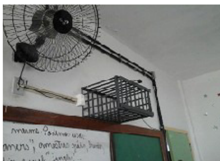
Ausência de caixas de som para uso do projetor - salas 1, 7 e 8
