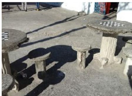
Bancos e mesas danificados – área externa próximo à quadra
