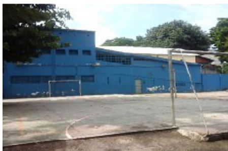
Quadra descoberta (situação sinalizada desde 2011)
