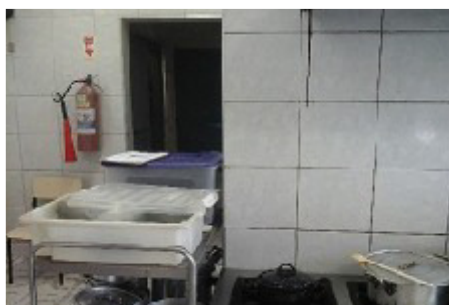
Instalações sanitárias em comunicação direta com a área de preparação de alimentos (ver comentário)
