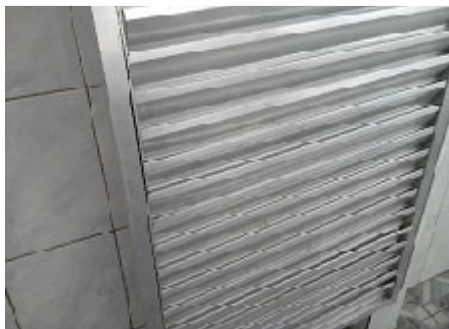
Ausência de maçaneta na porta (boxe para portador de necessidades especiais) – banheiro masculino prédio principal
