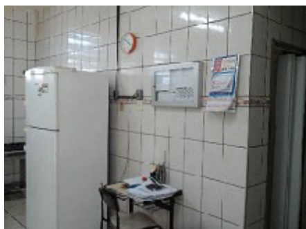
Instalações sanitárias em comunicação direta com a área de preparação de alimentos (situação sinalizada em 2015)
