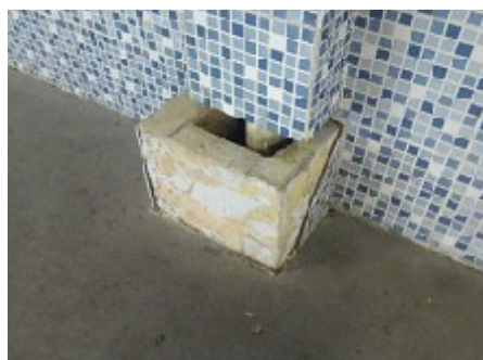
Queda de revestimento - térreo próximo à sala 3
