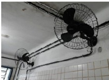
Ventiladores com defeito e com fiação exposta – sala 5
