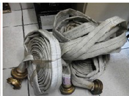
Mangueiras de combate a incêndio fora dos seus compartimentos (armazenadas no depósito)
