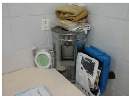
Ausência de instalações hidráulicas para uso do descascador, conforme informado pela Direção. Situação sinalizada desde 2014.
