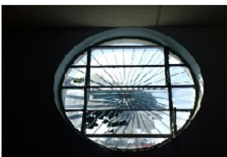
Vidro danificado no basculante
