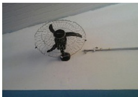
Ventilador danificado – sala 3
