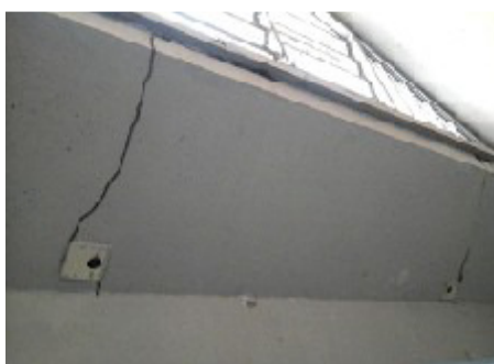
Infestação de cupim, conforme informado pela Direção – sala de judô
