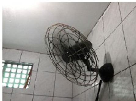
Necessidade de limpeza no ventilador
