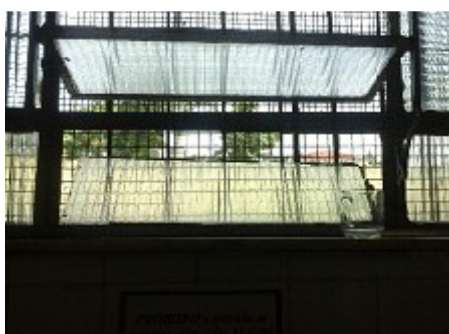
Vidro danificado no basculante
