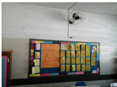
Todos os ventiladores com defeito – sala 2 prédio principal
