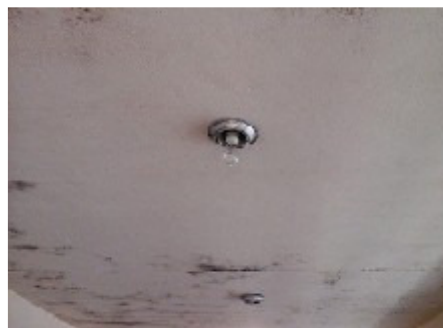
Lâmpadas ausentes/queimadas – vestiário masculino
