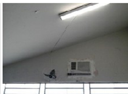
Aparelhos de ar-condicionado desligados devido à necessidade de aumento de carga elétrica, conforme informado pela Direção – todas as salas de aula (situação sinalizada em 2015)
