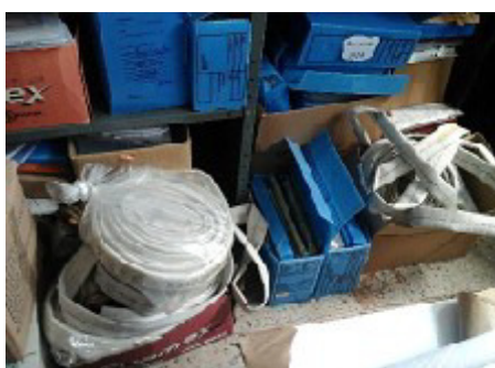
Todas as mangueiras de combate a incêndio fora dos seus compartimentos
