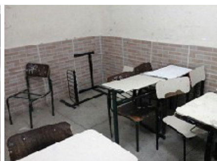
Mobiliário precário (situação sinalizada desde 2014)
