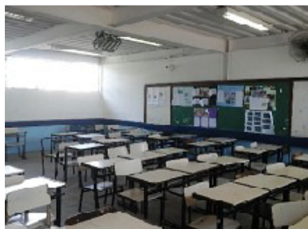
Ausência de aparelho de ar-condicionado - salas 1 a 9 (prédio anexo 2). Situação sinalizada em 2015.
