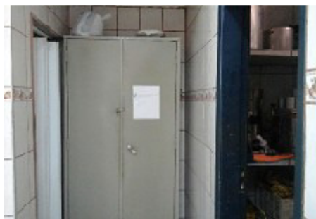
Instalações sanitárias em comunicação direta com a área de armazenamento de alimentos (situação sinalizada em 2015)
