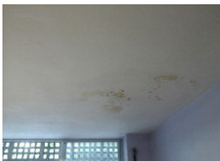
Pintura desgastada decorrente de infiltração sanada, conforme informado pela Direção – laboratório de ciências
