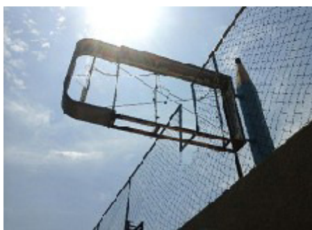
Totem danificado (situação sinalizada em 2015)
