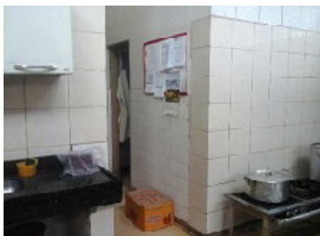
Instalações sanitárias em comunicação direta com a área de preparação de alimentos (ver comentário)
