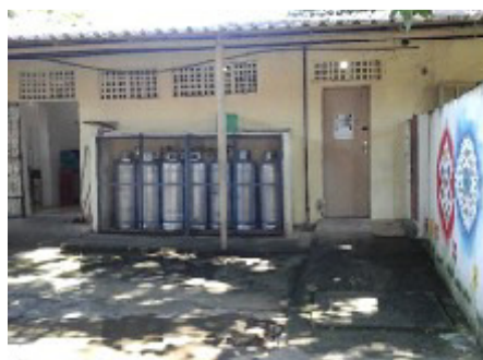
Abrigo de botijões de gás em local onde há circulação de alunos (situação sinalizada desde 2013). Ver comentário.
