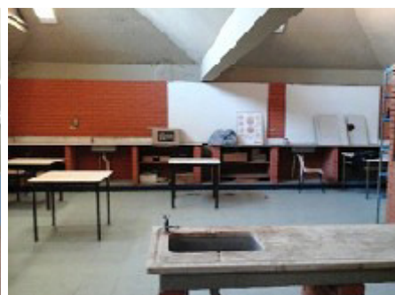
Ausência de ventilador de parede (só tem ventilador de teto) – laboratório de ciências
