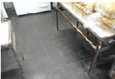
Mesas de madeira (material inadequado em despensa) e enferrujadas
