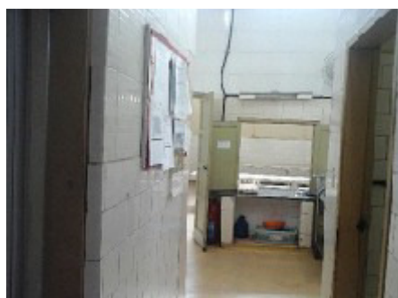
Instalações sanitárias em comunicação direta com a área de armazenamento de alimentos (ver comentário)
