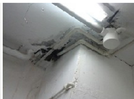
Queda de reboco – banheiro masculino subsolo (situação sinalizada desde 2014)
