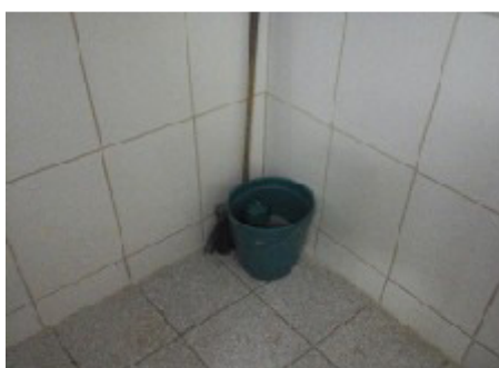
Banheiro masculino sendo utilizado para guarda de material de limpeza - próximo ao refeitório
