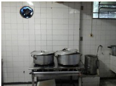
Ausência de coifa
