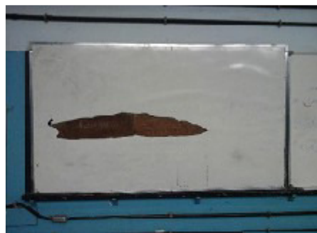
Quadro danificado - sala 2 (situação sinalizada em 2015)
