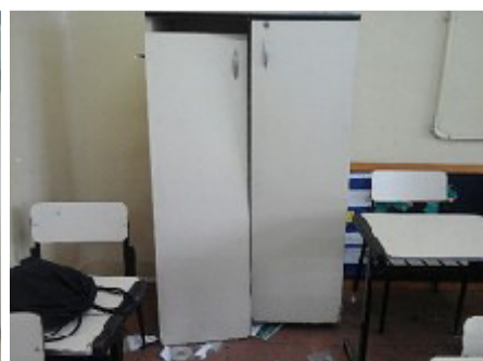
Armário danificado - sala 8
