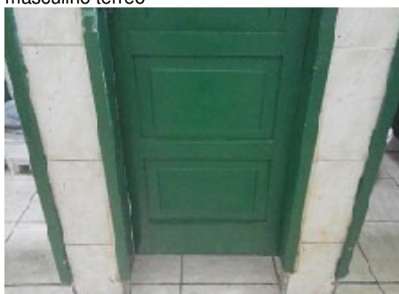
Boxe interditado – banheiro masculino térreo
