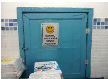
Ausência de mangueira de combate a incêndio – térreo, 1º e 3º andares
