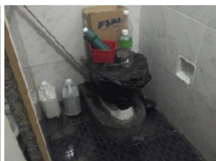
Boxe sendo utilizado para guarda de material de limpeza – banheiro masculino
