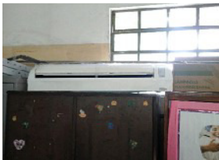
1 Aparelho de ar-condicionado não instalado armazenado na sala de aula – sala 9
