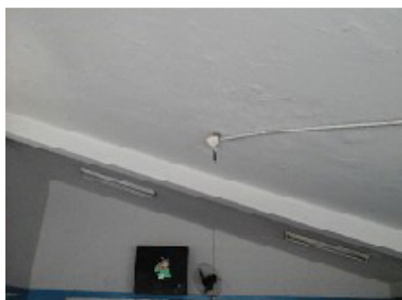
Ausência de projetor – salas 11, 12, 13, 14, 15, 16 e 17
